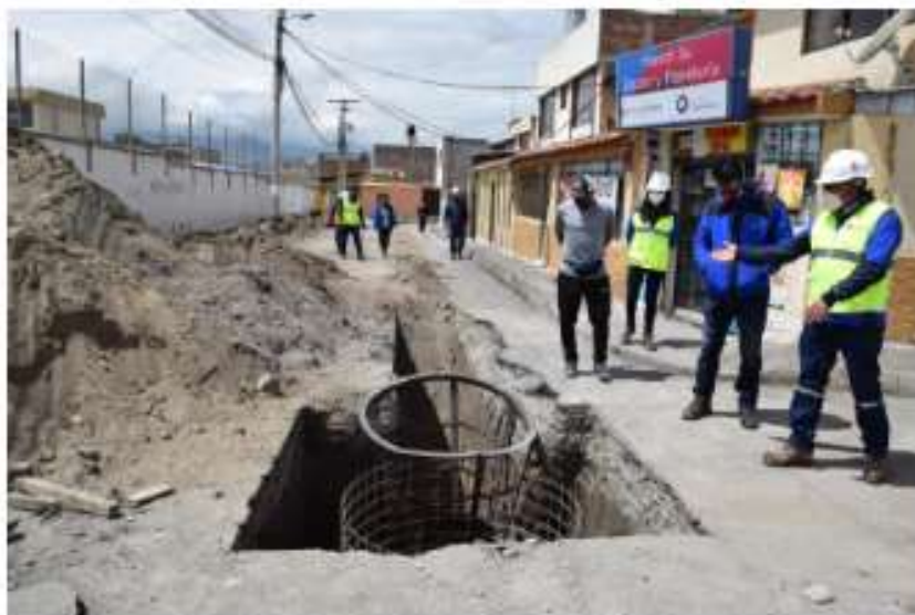
Foto de archivo obra de alcantarillado en la Primavera
