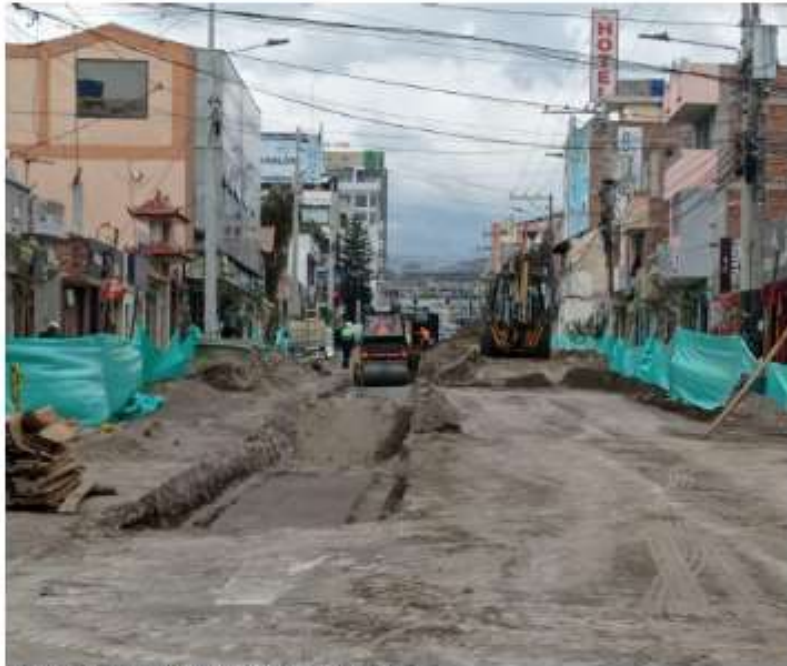
Trabajos en la calle Teniente Latus y Av. Carlos Zambrano
