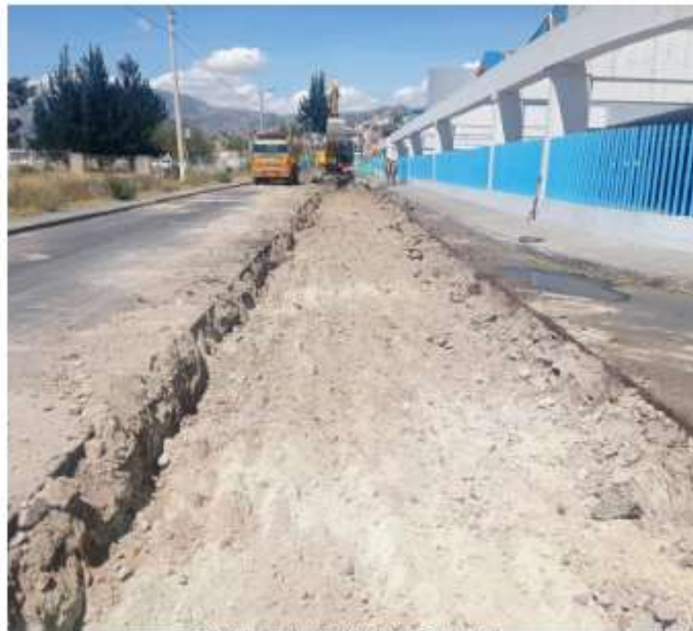
Trabajos en el sector Multiplaza Saboya Civil
