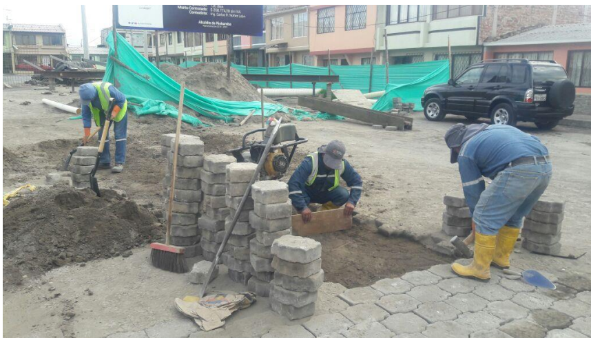
Personal de EP-Empar, durante la intervención de los trabajos
