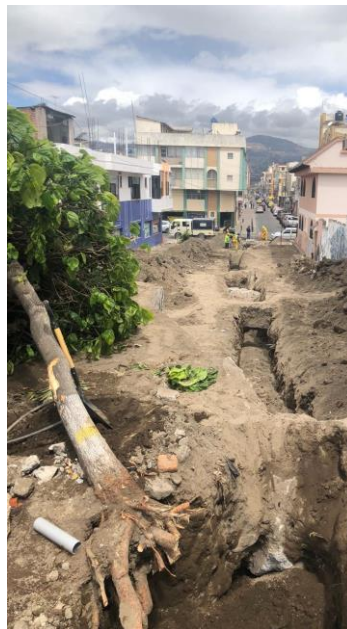
Trabajos realizados en las escalinatas de la calle Veloz y Orozco
