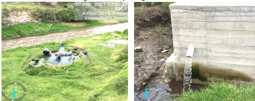
Fotografía No. 126 y 127 Agua de Vertiente
